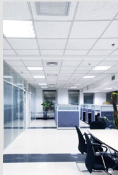
Kantoor licht + ventilatie
